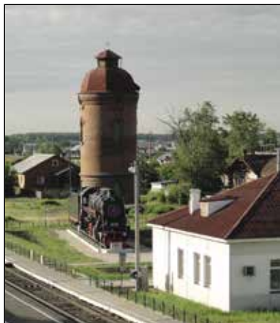
Водонапорная башня, ж/д ст. Чистоозёрная
