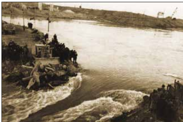
Перекрытие русла р. Обь при строительстве Новосибирской ГЭС (1956 г.)
