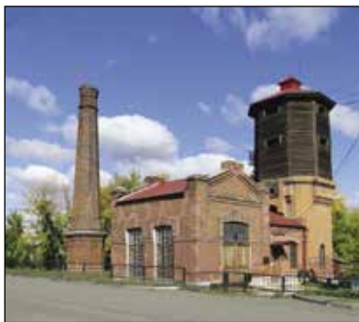
Комплекс сооружений насосной станции, г. Каргат
